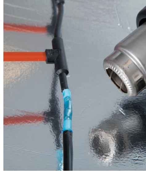
Рис. 13. Термоусадка соединительной гильзы техническим феном
