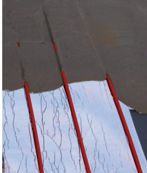
Рис. 24. Залейте стяжку пола поверх стержней теплого пола UNIMAT
