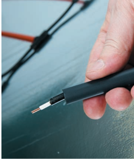
Рис. 11. Процесс надевания термоусаживаемой трубки на соединительный провод ВВГнг
