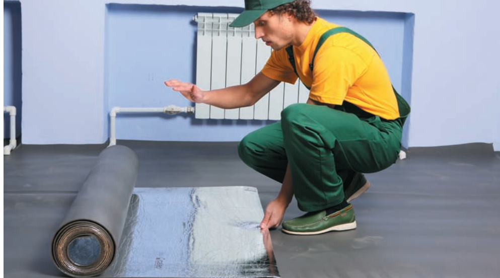
Рис. 3. Укладка теплоотражающего материала
