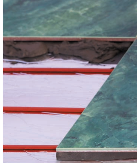
Рис. 26. Монтаж керамической плитки поверх карбонового мата UNIMAT RAIL/ UNIMAT BOOST
