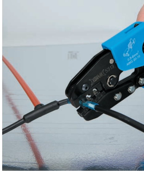
Рис. 12. Обжатие клещами соединительной гильзы
